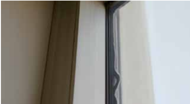
Un joint d'étanchéité défectueux diminue les capacités d'isolation d'une fenêtre.
